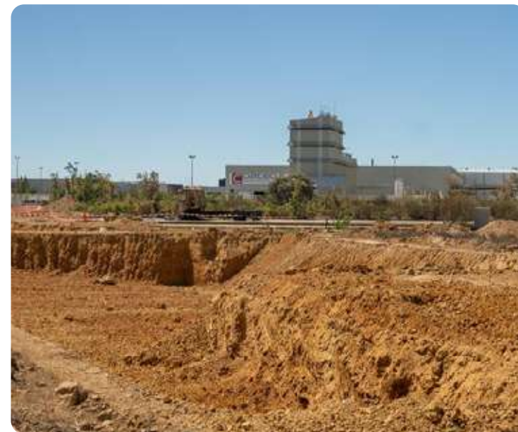
Obras en el Polígono de Villadangos del Páramo. MIGUEL F. B.
