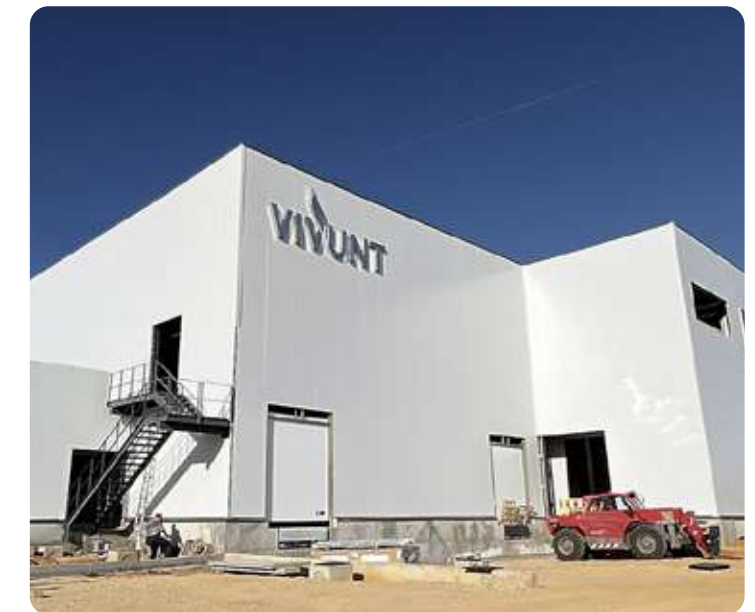
Obras de la fábrica en Villadangos del Páramo (León).
